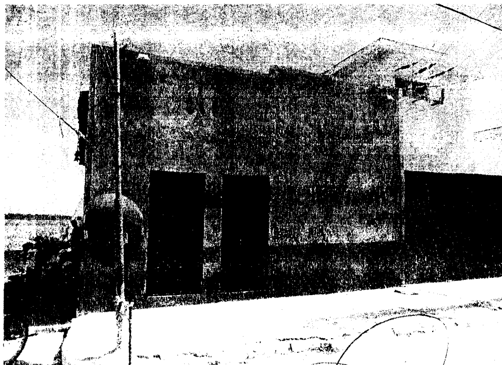
Foto 03 - Vista área externa.
